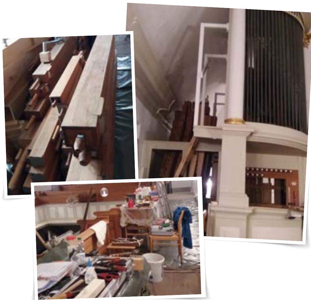
Alle Pfeifen wurden ausgebaut und geputzt.
